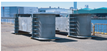
写真4 深梁 (大阪南港)
