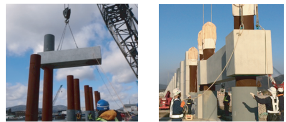
写真1 ブロック据付状況(左:底版 右:防波版) Photo 1 Installation of block (left: bottom block, right: sea wall block)
